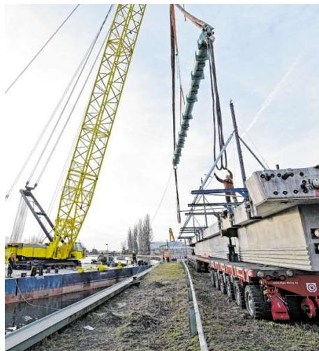
Vom Tieflader an den Schwimmkran und dann ab ins Wasser: Das 135 Tonnen schwere Bauteil wird an den Haken genommen.
